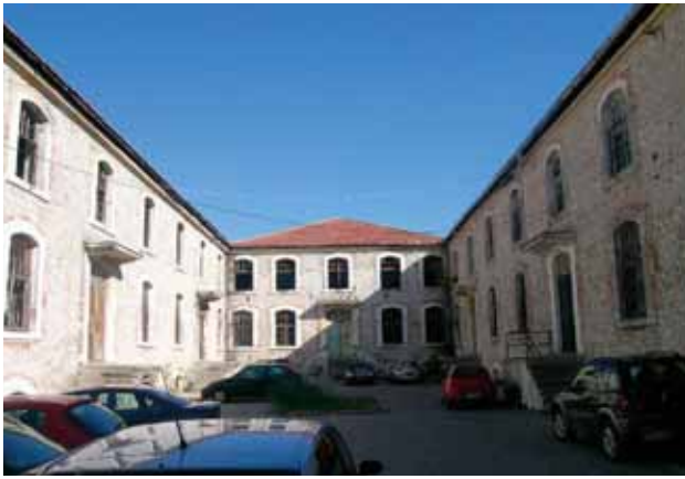
Το συγκρότημα «Π-» των Καπναποθηκών με είσοδο επί της οδού Καπνεργατών. Δυτική (κύρια) όψη.
