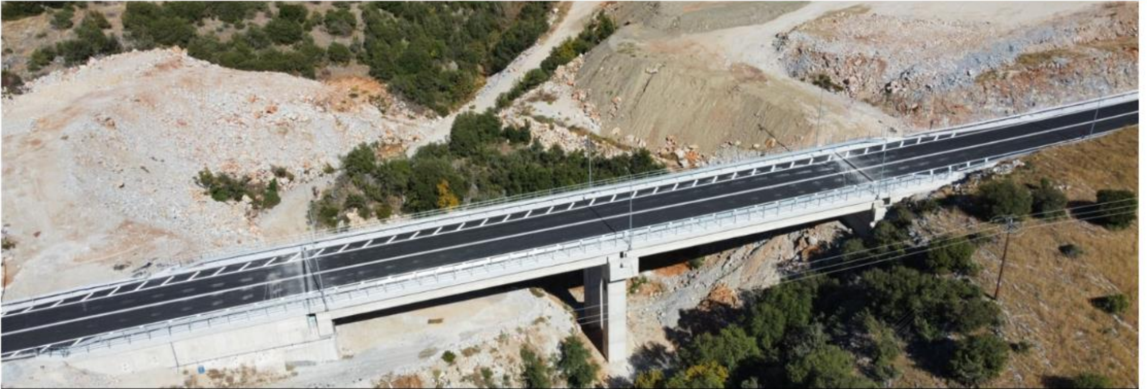
Κατασκευή Γέφυρας Μαρμαριάς επί της ΕΟ Νο 14 Δράμας - Ξάνθης μετά των προσβάσεων
